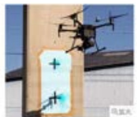
実証実験では、ドローンに搭載したカメラで、橋脚部分の状況を確認する。一部トラブルも「実用性は十分」
