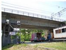
JR西日本北陸本線木浦橋梁 (富山県) アクアシール1400
