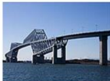
東京ゲートブリッジ (東京都) アクアシール1400
