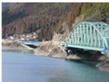
国道2・29号橋梁 (兵庫県宍粟市) アクアシール1400
