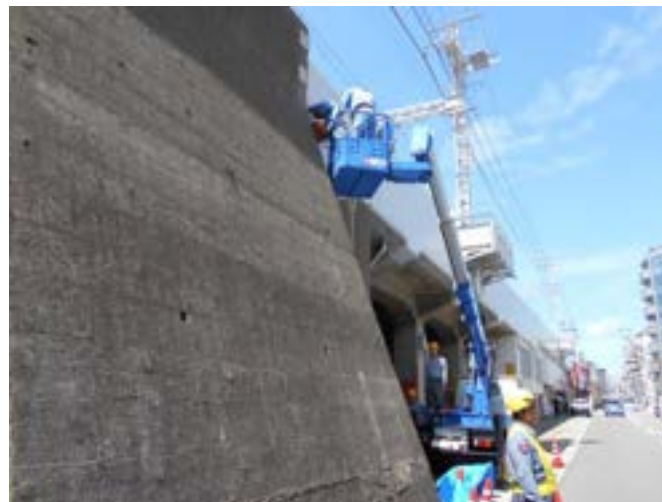
高所作業車による作業状況
