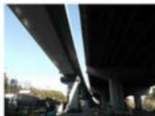
近畿自動車道八尾パーキングエリア (大阪府) アクアシール1400
