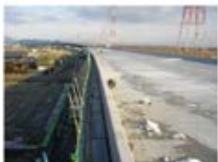
東海環状祖父江南高架橋 (愛知県) アクアシール1400
