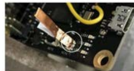
実作業（銅テープ貼付）
