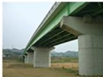
貴志川大橋 (和歌山県) アクアシール1400
