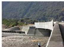
元川橋 (高知県安芸市) アクアシール1400
