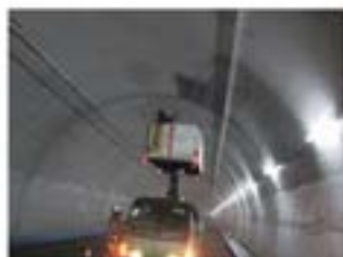
首都圏中央連絡自動車道 (圏央道) (神奈川県) アクアシール1400
