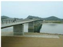
各務原大橋 (岐阜県) アクアシール1400
