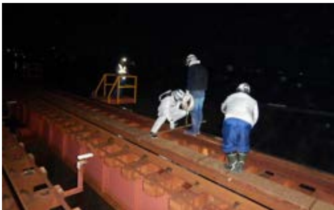
線路内での夜間作業の状況
