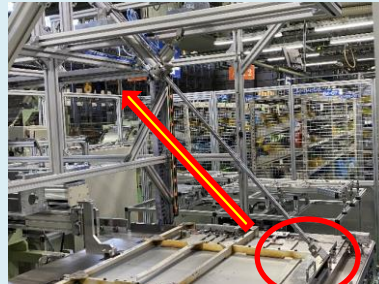
<②アップパー自動開> シリンダで治具の取手を引っ掛けアップパーを引き上げる。
