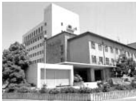
兵庫県立工業技術センター
